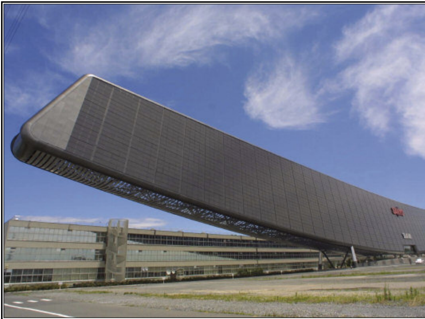
Font 20. El Solar Ark és una estructura de 315 m de llargada, formada per més de 5.000 panells de plaques fotovoltaïques. A l'interior hi ha un museu ambiental i laboratoris. És el símbol de la innovació i la recerca en tecnologies netes de la ciutat de Gifu, centre d'una de les tecnòpolis japoneses.
