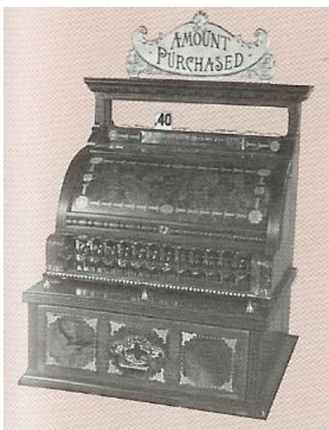
Figura 16 – Màquina registradora amb calaix, rotlle de paper i timbre de 1885
